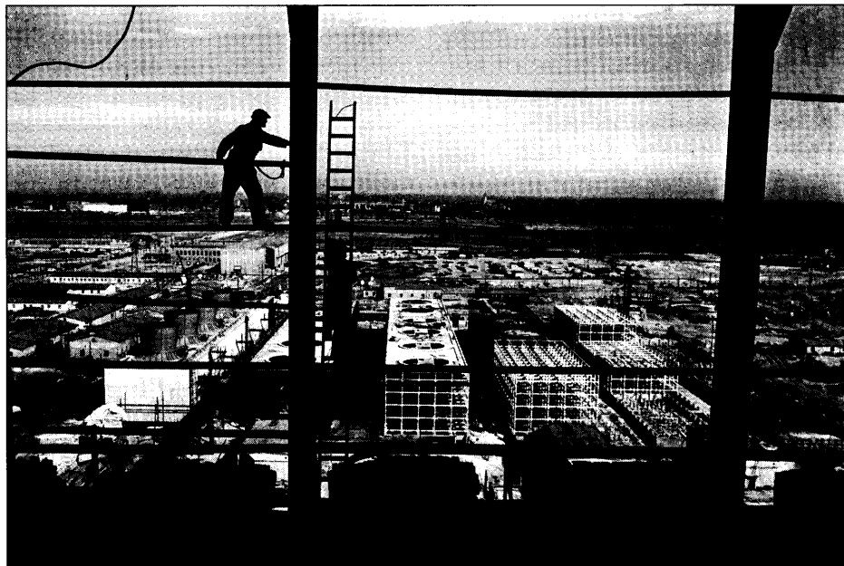
Großbaustelle des Kraftwerkes Lübbenau (DDR), 1959 (Foto: dpa)
